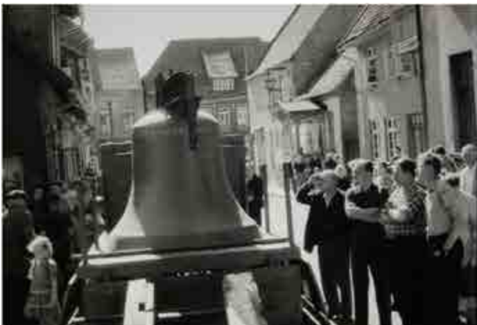
Einbringen der Stahlglocke in den Kirchturm 1957; aus dem Bilderarchiv
