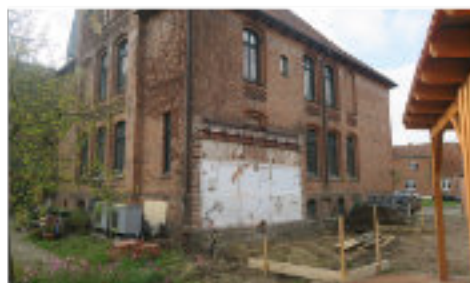
Bausituation Ende Oktober 2020
