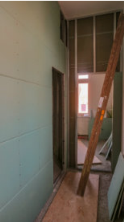
Hier entstehen die neuen Sanitäräume
