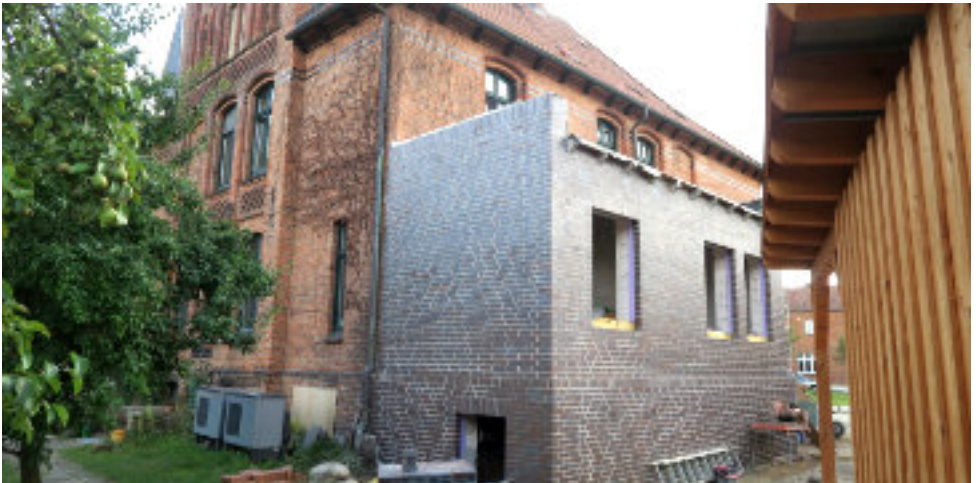
Fertigstellung der Klinkerarbeiten am neuen Anbau
